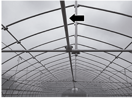
写真1 タイバーによる補強
